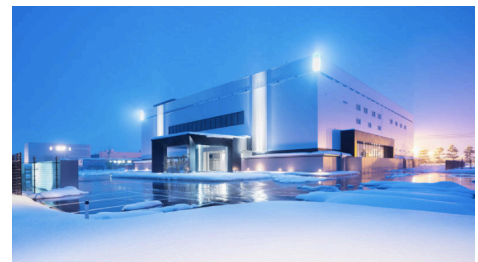
新潟・長岡データセンター外観
