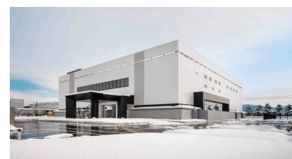
新潟・長岡データセンター外観
