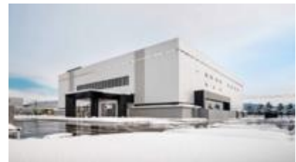
新潟・長岡データセンター外観
