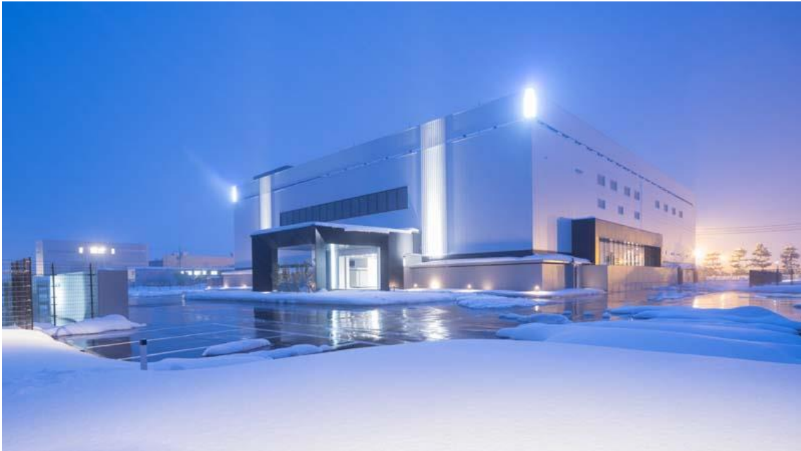
<新潟・長岡データセンター外観>
